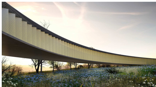
Vue de la partie en porte-à-faux de l'anneau
