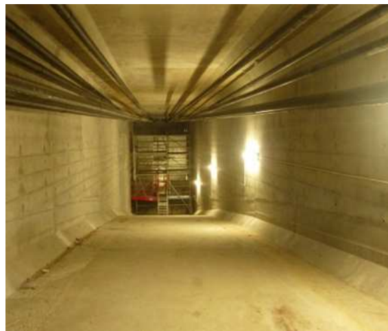
Vue de l'intérieur du fléau depuis le voussoir V11
