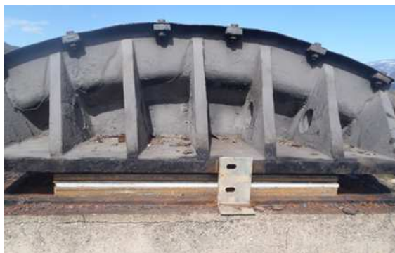
Mise sur plaque de glissement des semelles
