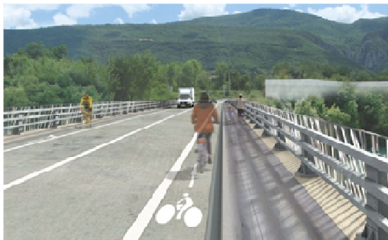
Insertion piétonne sur le tablier
