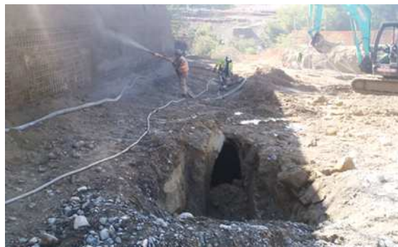
Galerie sous à l'emplacement de la pile en rive gauche
