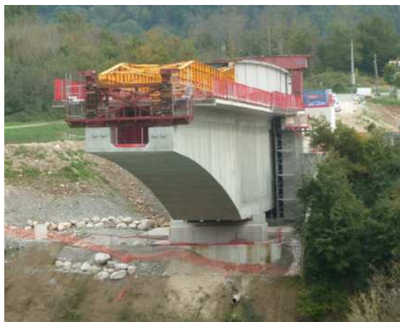
Exutoire en rive gauche
