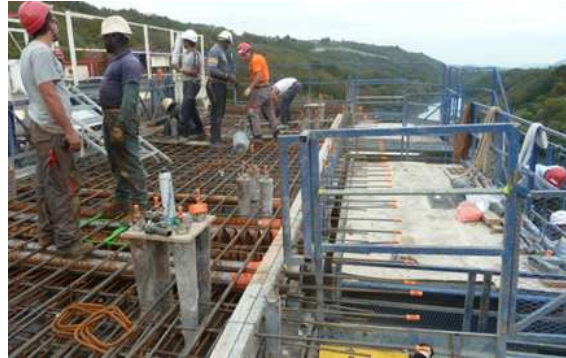
Vue depuis l'équipage au moment du ferrailage du hourdis
