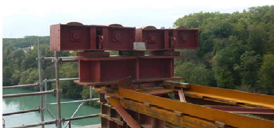
Appui de lançage
