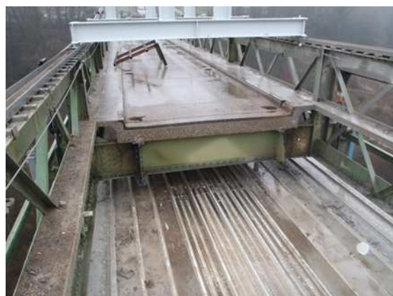
Découpe des dalles béton et évacuation par chariot sur rail (en blanc)
