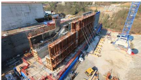
Travée contrepoids en réalisation - Rive gauche
