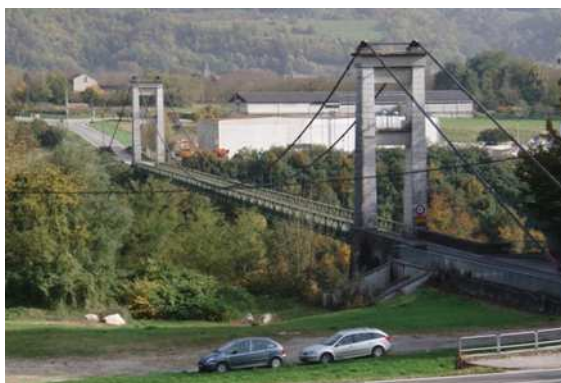
Ancien pont suspendu de la RD32
