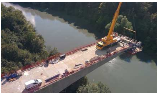
Démontage de l'équipage en rive gauche avec une grue 100 tonnes
