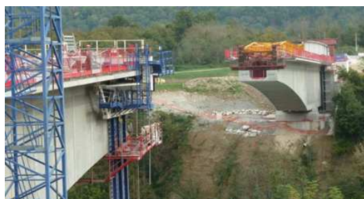
Avancement rive gauche et rive droite au 15/10/2014
