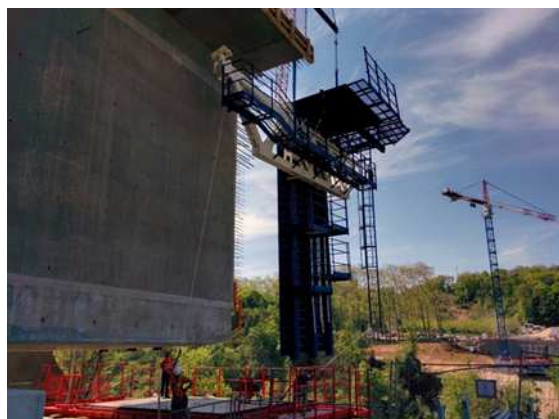
Mise en place de l'équipage en bout de pile
