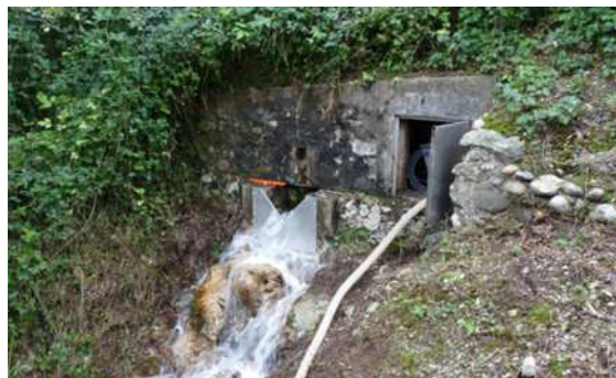
Seuil permettant de mesurer le débit de la source
