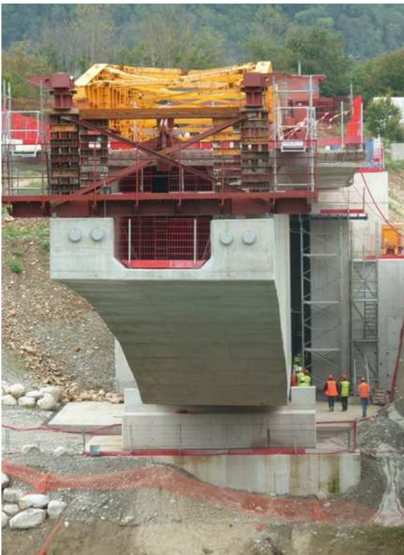
Vue du fléau gauche complet avec les chaises de lancement et la charpente derrière
