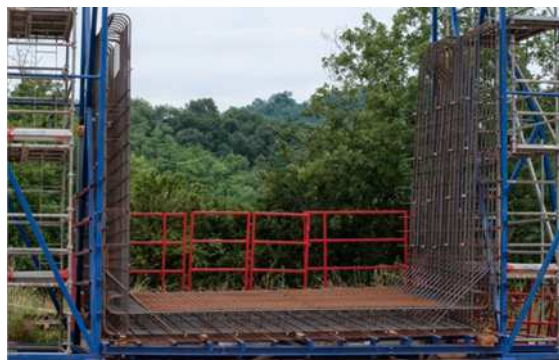
Réalisation du U de ferrailage sur gabarit
