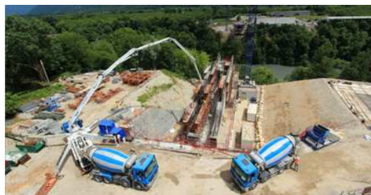
Béton acheminé par camion toupie
