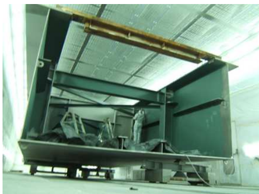
Fabrication et peinture des tronçons de charpentes
