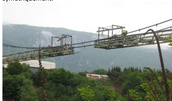
Dépose de la charpente métallique en partant du centre
