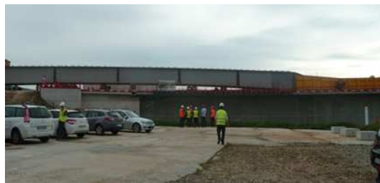
Vue de la charpente et de son avant-bec (en jaune)
