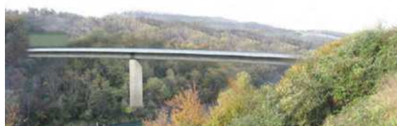
Tablier mixte acier-béton avec appui intermédiaire
