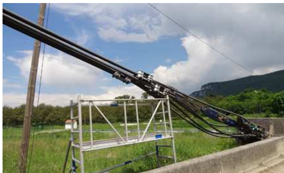
Dispositif de reprise de la tension au niveau des ancrages
