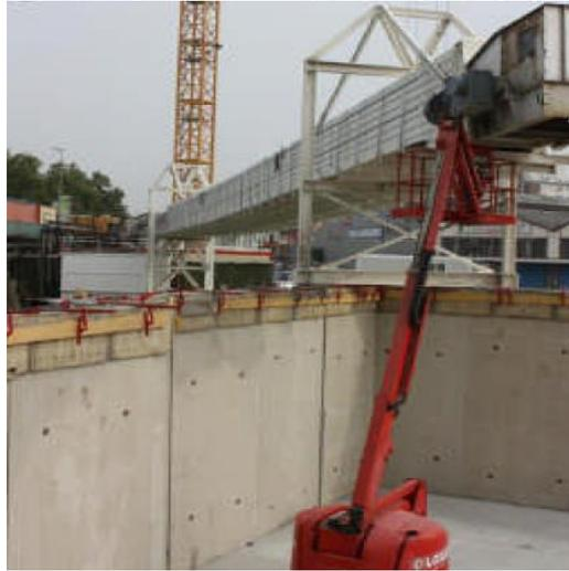
Sortie du tunnel par un convoyeur à vis vertical
