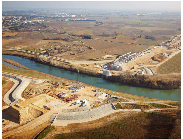
Viaduc du Vidourle, Gallargues le Montueux
