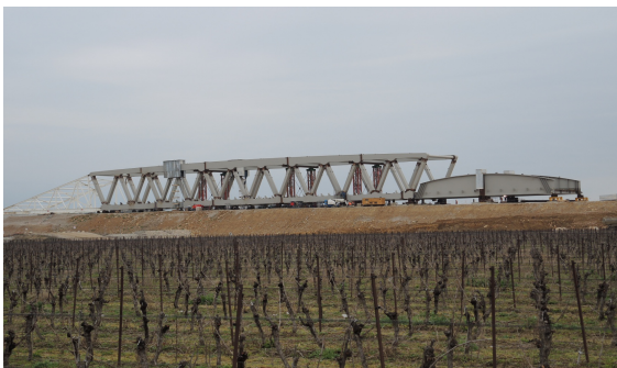
Warren du Vidourle en cours de montage
