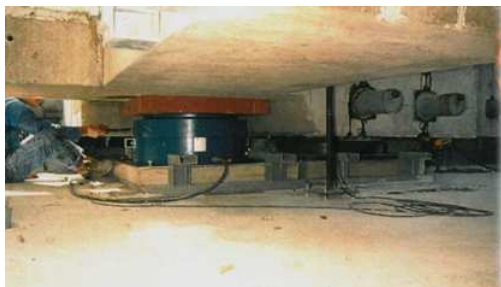
Sciage du pied de pile et installation des vérins
