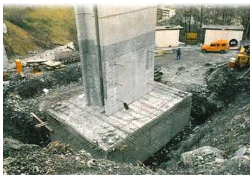
Dégagement des fondations
