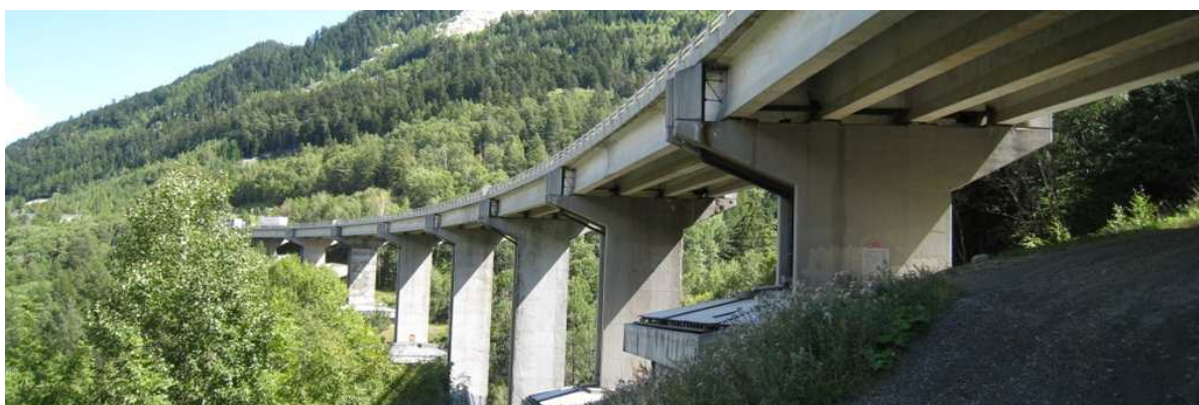
Vue générale du viaduc
