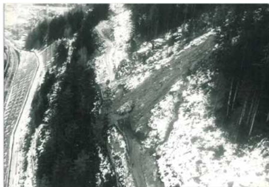
Glissement de terrain 1977 provoqué par le début du terrassement
