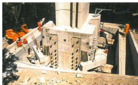
Installation de la mâchoire précontrainte
