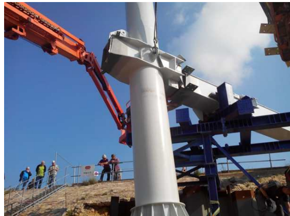
Mise en place des grands mâts
