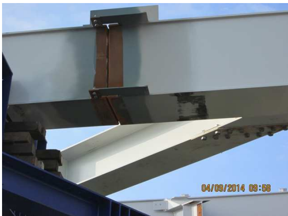
Mise en place des poutres principales
