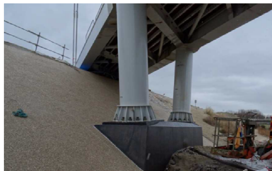
Appuis des grands mâts
