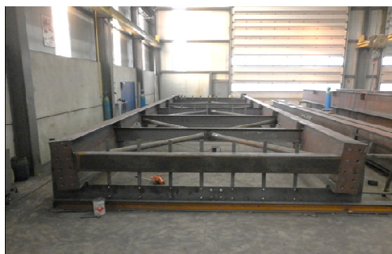
Fabrication en atelier
