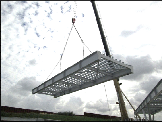
Pose des tronçons sur site
