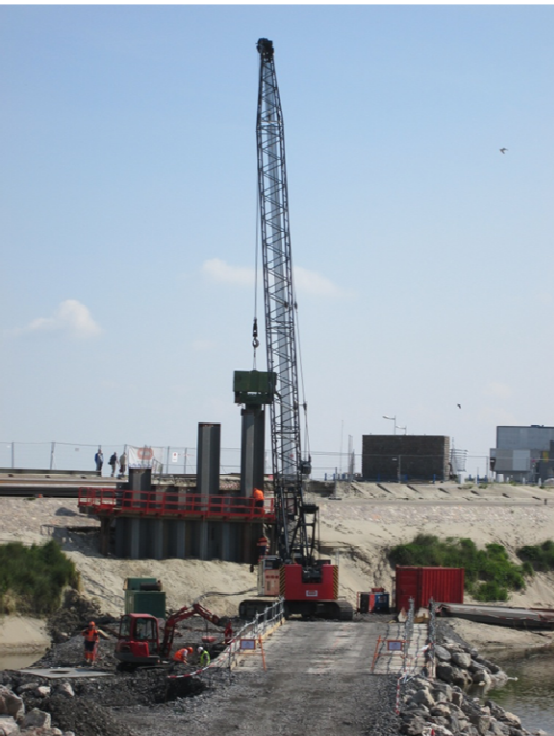
Réalisation des batardeaux P10/P11/P18/C19
