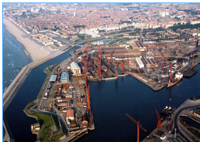
Les « Chantiers de France » en activité avant 1986
