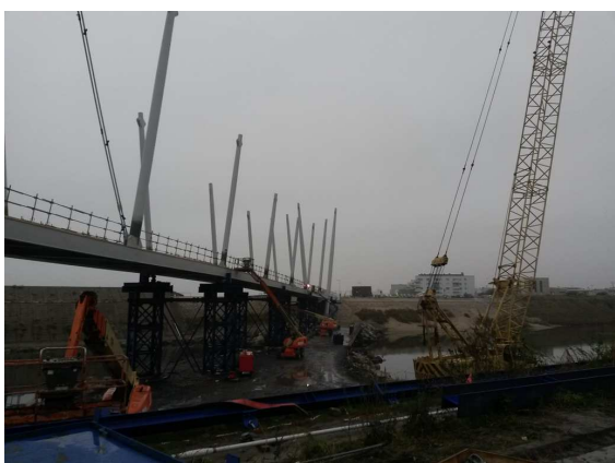
Mise en place des haubans
