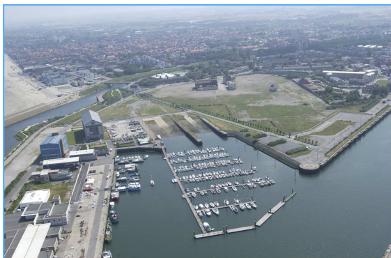
Les anciens « Chantiers de France » après 2000
