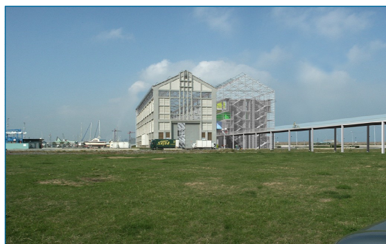
Le FRAC, l'AP2 et la passerelle piétonne
