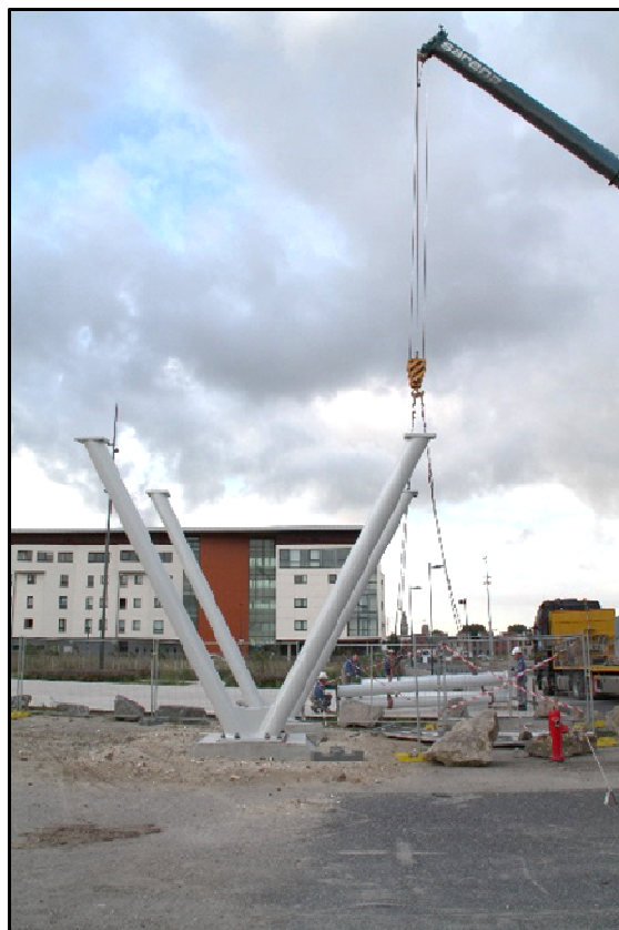
Pose des pieds sur site
