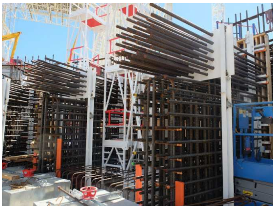
Figure 11 – Les armatures du bioshield du Tokamak
