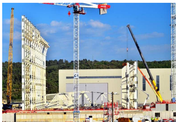
Figure 6 – Charpente du bâtiment d'Assemblage
