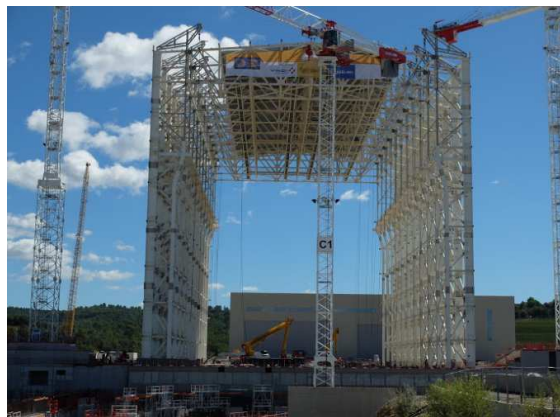
Figure 12 – Le bâtiment d'assemblage
