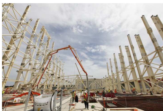
Figure 7 – Montage des poteaux et de la toiture au sol
