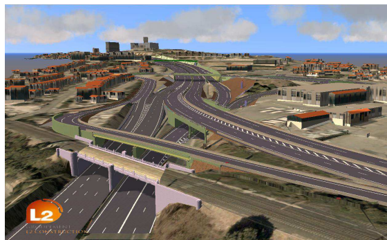
Echangeur des Arnavaux
