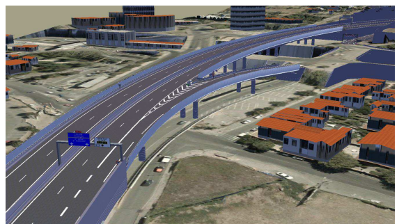
Viaduc de Frais Vallon
