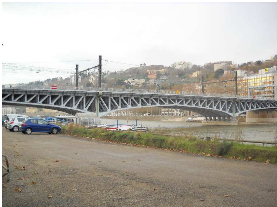
Viaduc de la Quarantaine, décapée par la technologie UHP en 1997.
