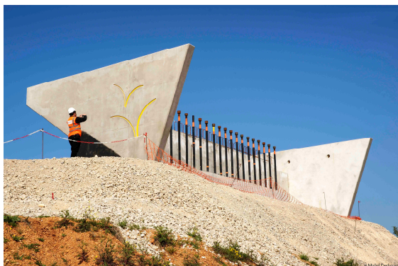
Viaduc du Vistre
