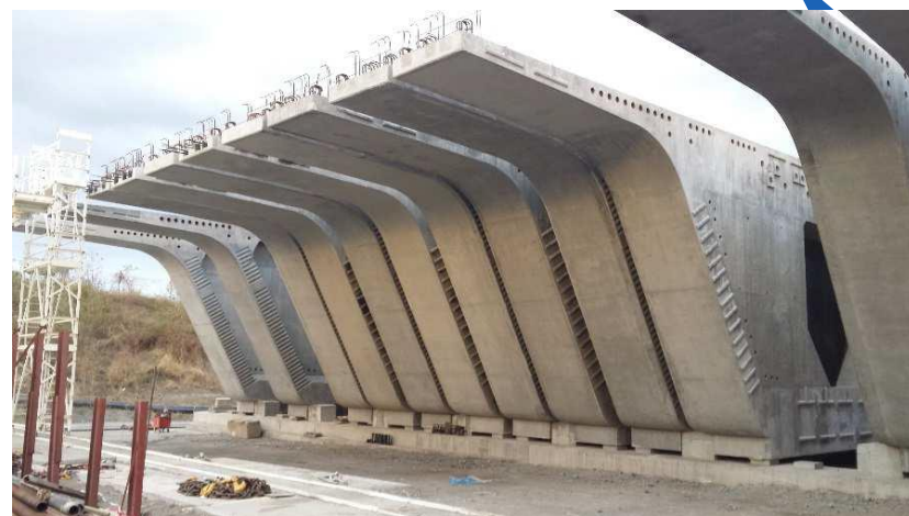
Voussoirs sur pile
