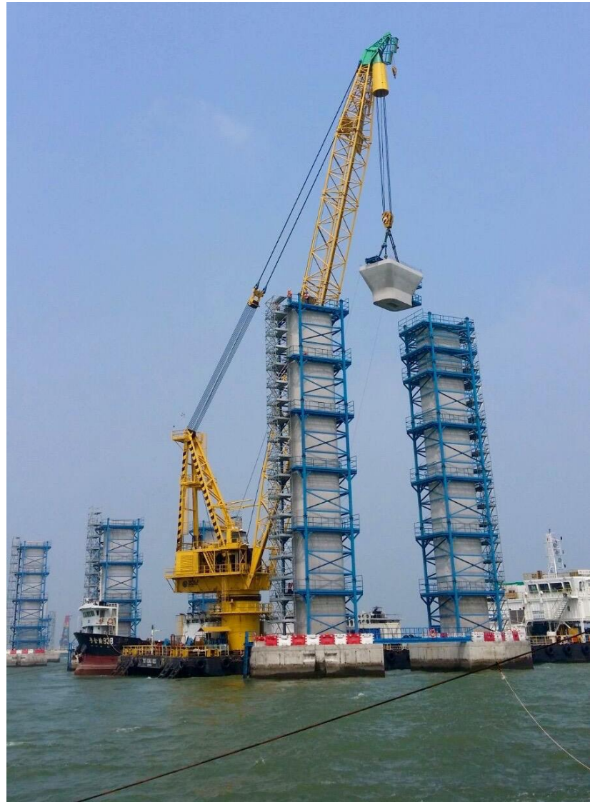
Structure métallique assurant la stabilité en phase de construction
