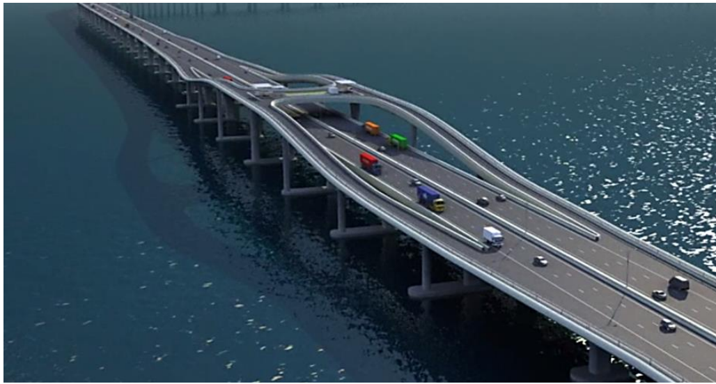
❑ Ouvrage de retournement
