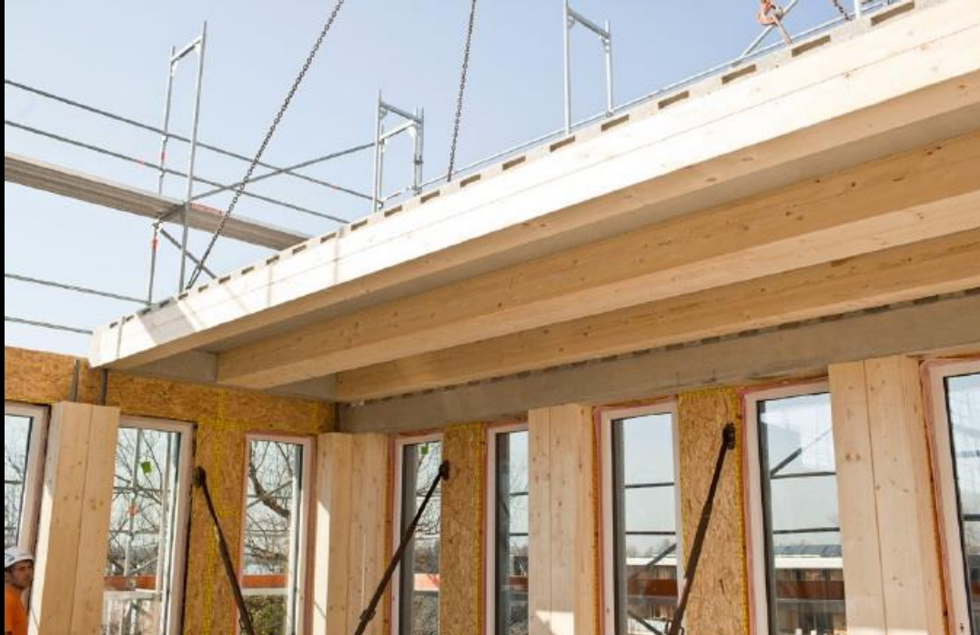
Bureaux Poteaux-poutres Noyau béton
