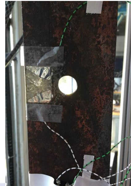
Photo de la jauge de fissuration www.ifsttar.fr
