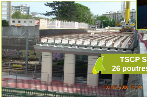
Doublage du Pont Pinel à Rouen 17 poutres de 27 m
