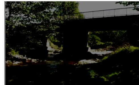
Photo 3 : Ouvrage sur fond rocheux réputé peu sensible à l'affouillement
