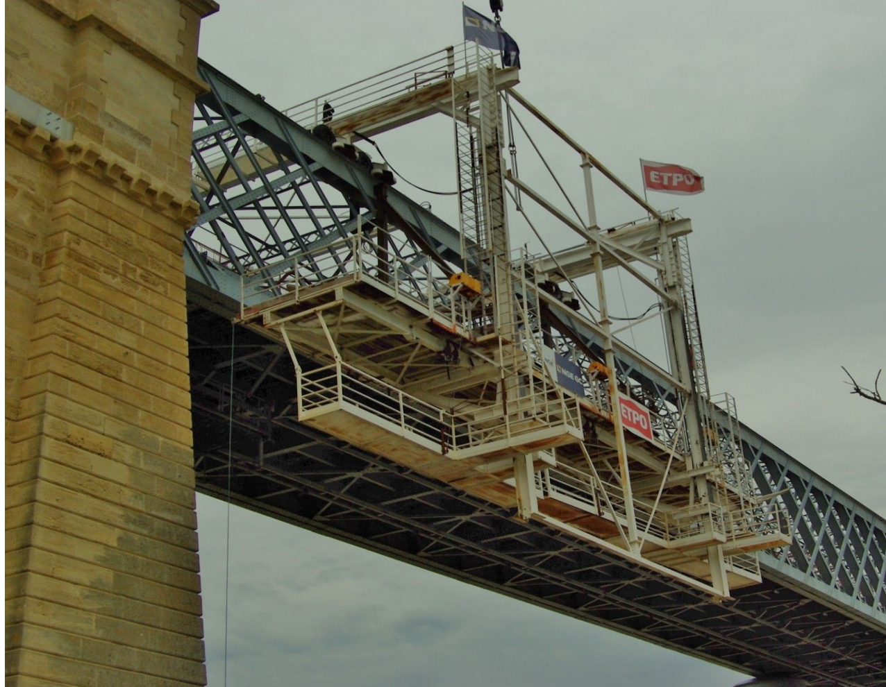
Pose passerelle encorbellement
