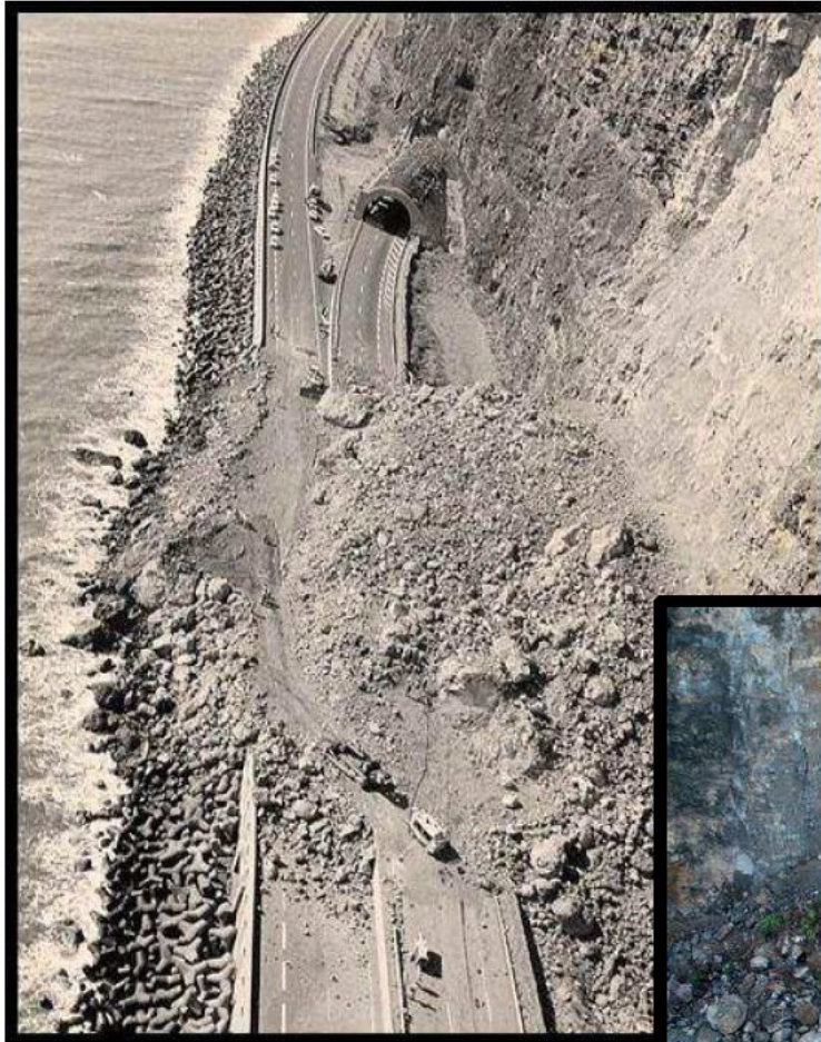
Effondrement de grande ampleur
