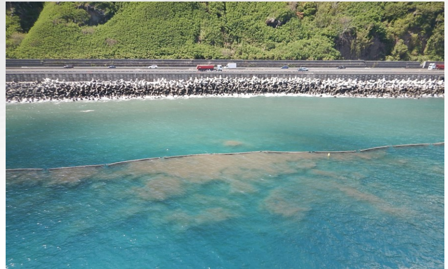
Barrage anti-MES – Pointe du Gouffre
