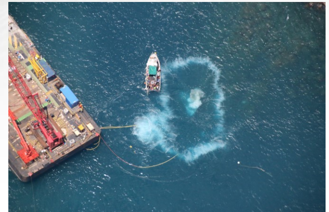
Rideau de bulle dans le cadre d'une opération de fragmentation (photo NortekMed)
