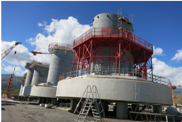
Préfabrication des piles au Port Est
