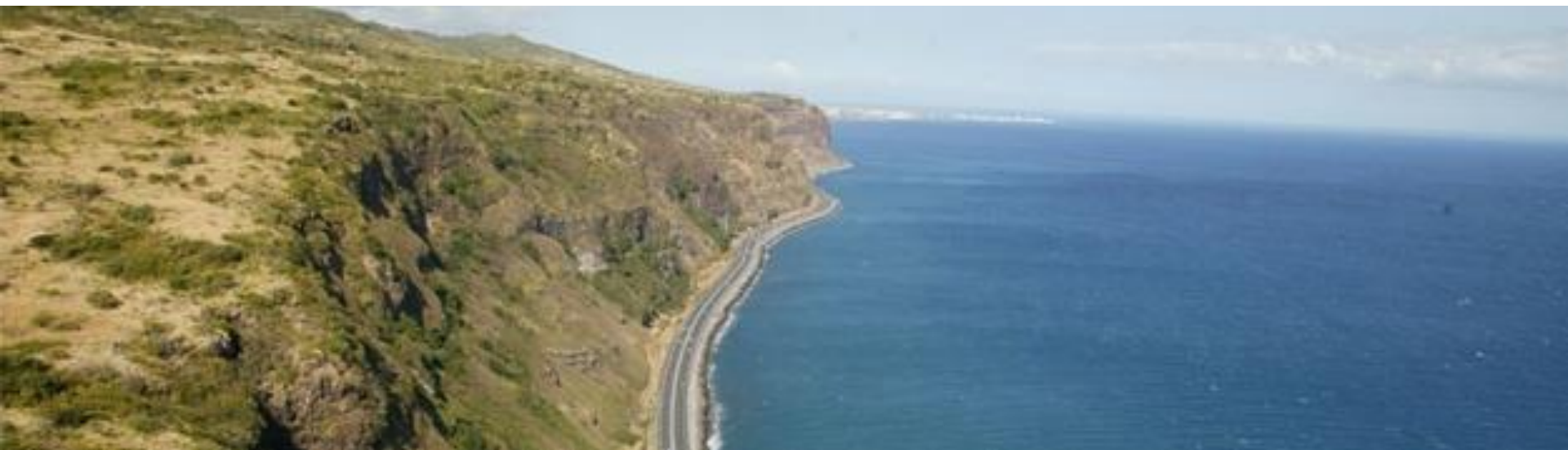
Photos du site avant travaux
