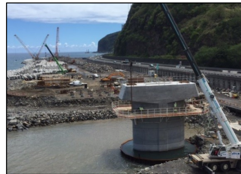
Pile P1: Décembre 2015
