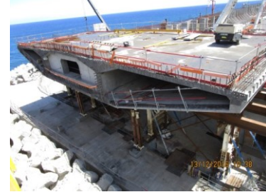
Décoffrage hourdis supérieur et démontage outil B
