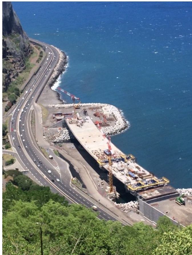
AFGC, Viaduc de la Grande Chaloupe, 23 Novembre 2017
