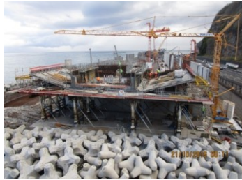
Réalisation du fond de moule et pose des âmes préfabriquées
