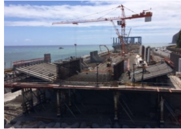
Bétonnage hourdis inférieur (70m3) + âmes verticales (24m3)
