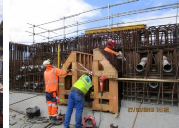
Coffrage et bétonnage du bloc d'entretoise (45m3)
