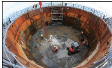
Vidange du batardeau
