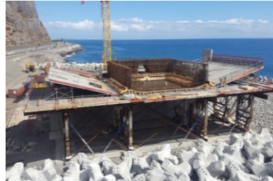
Ferraillage du hourdis inférieur, bloc d'entretoise et âmes verticales VSC + VCC
