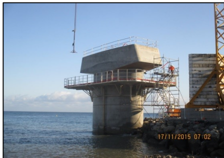
Pile P3: Novembre 2015
