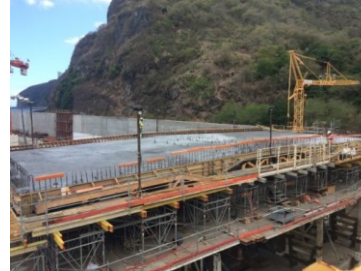
Bétonnage hourdis supérieur (140m3)
