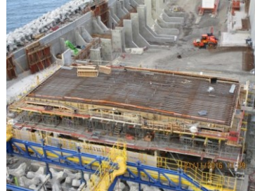
Ferraillage hourdis supérieur
