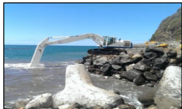
Terrassement du fond de souille
