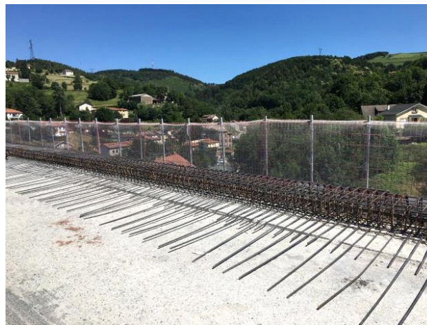
Ferraillage des longrines en encorbellement sur lesquelles seront scellés les dispositifs de retenue
