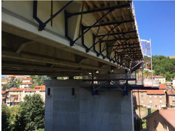
Platelage en encorbellement au niveau du tablier, tour d'accès, appuis provisoires sous chaque poutre
