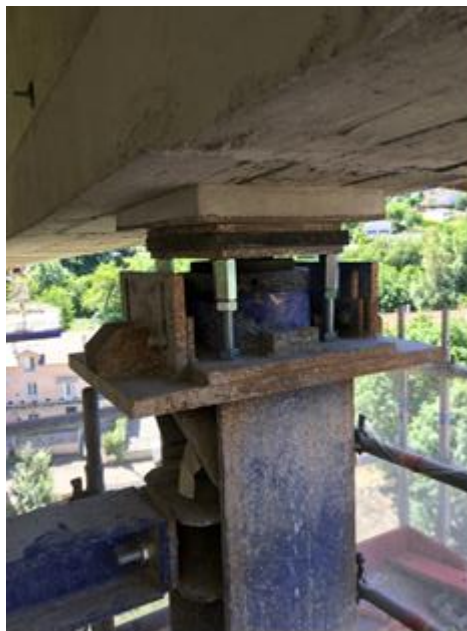
Détails sur dispositif d'appui provisoire
