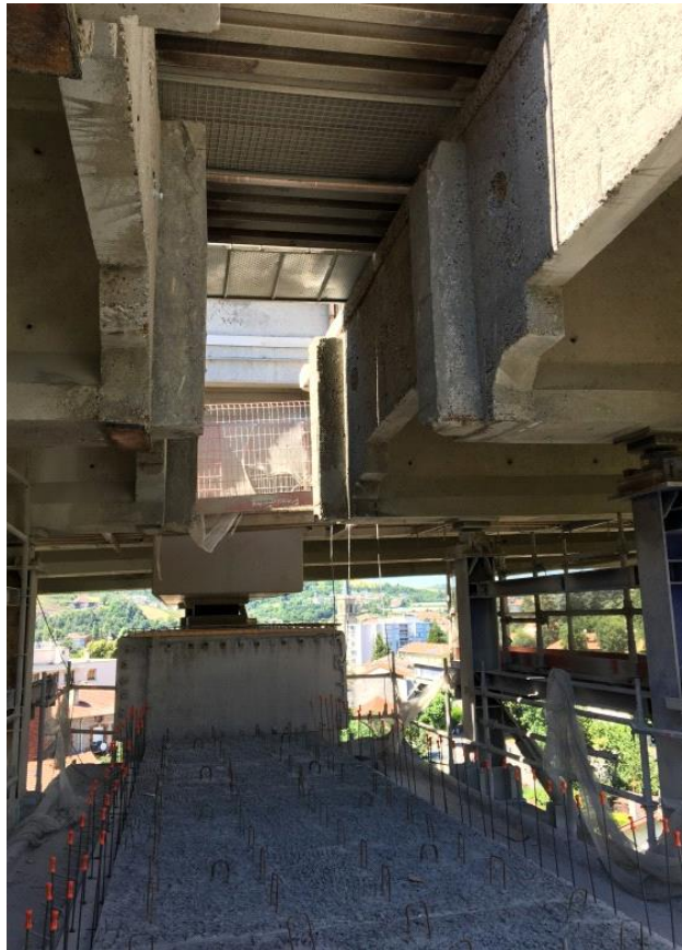
Chevêtre et tenon démolis (au premier plan, tablier Sud) et nouveau chevêtre, entretoise et appareil d'appui définitif (arrière-plan, tablier Nord)
