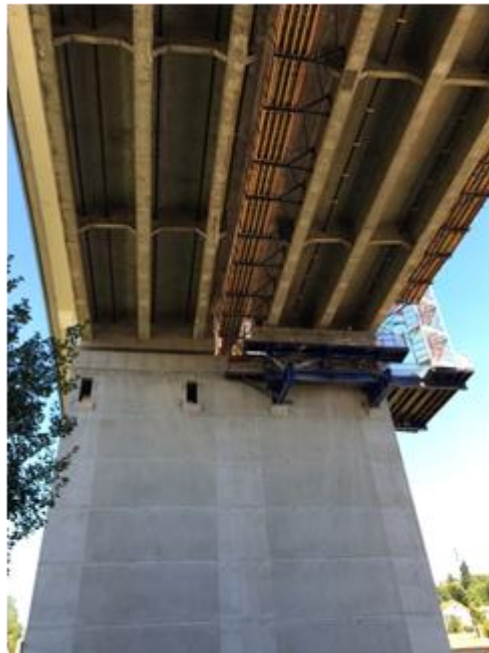
Vue de dessous du tablier : platelage indépendant de 26 tonnes pour chaque pile, ouvertures pour appuis provisoires côté NORD et platelage de travail entre les tabliers et en encorbellement
