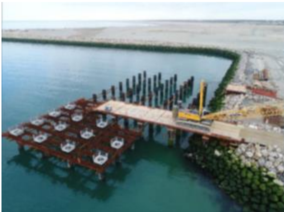
Pose des chapiteaux
