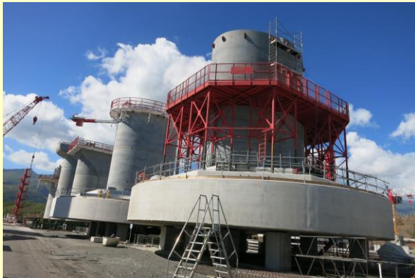
Préfabrication des piles au Port Est
