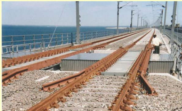
Viaduc du Storbelt
