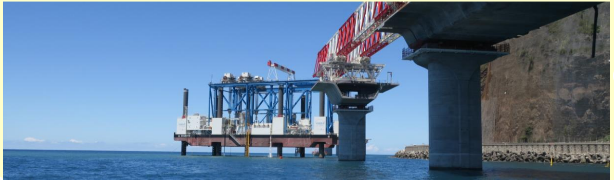
Pose en mer depuis la barge Zourite
