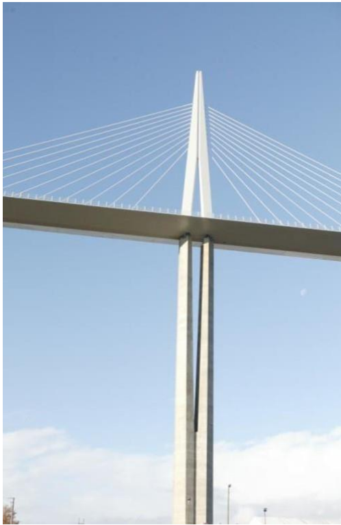
Viaduc de Millau – 1989 – 2001
