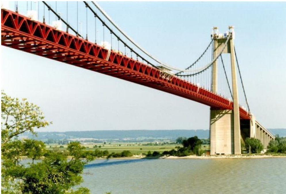
Réparation du pont de Tancarville
