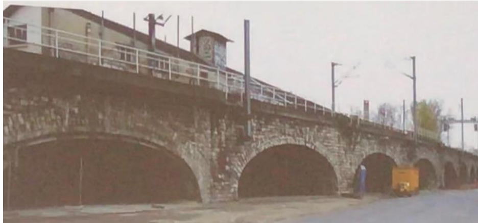
Fig. 2 : Le viaduc de Saint Ouen
