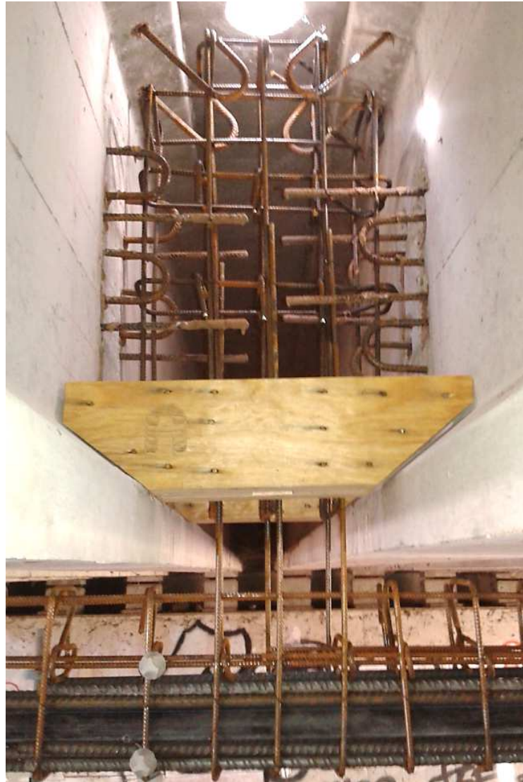
Mise place des ferrillages
