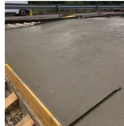
Bétonnage d'une DDT
