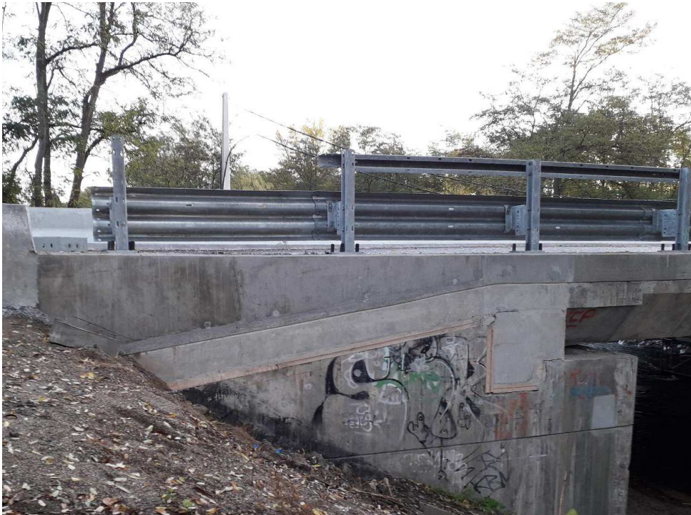
DDT de l'ouvrage amont
