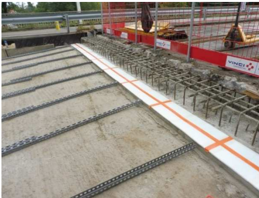
Ferrailage d'une poutre d'about
