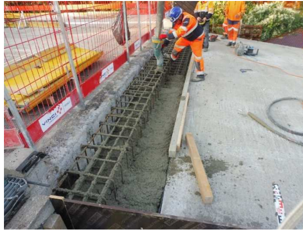
Bétonnage d'une poutre d'about
