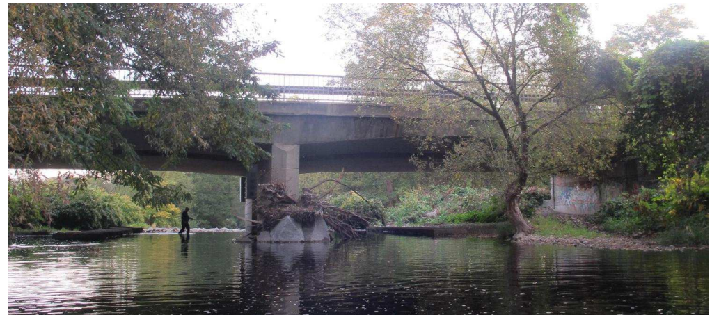
Vue depuis l'amont
