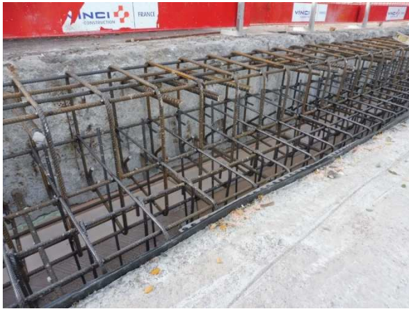
Ferrailage d'une poutre d'about
