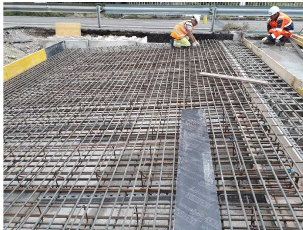
Ferrailage d'une dalle de transition.
