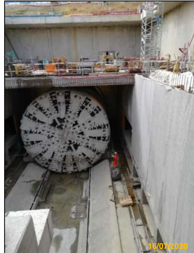
Arrivée du tunnelier dans la station
