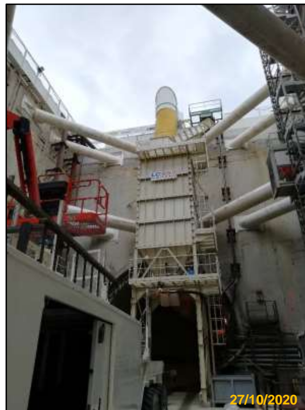
Installation de la trémie pour la GNT
