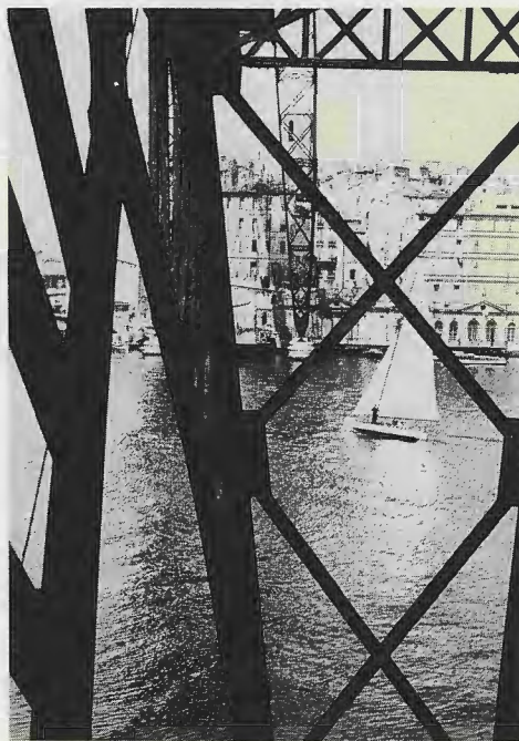
Voiliers sous le Transbordeur. A droite, les services du Contrôle Sanitaire.
