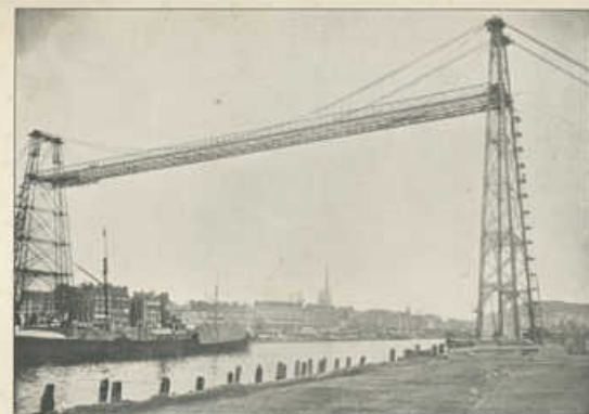
LE PONT TRANSBORDEUR DE ROUEN. Vue prise depuis le pont.
