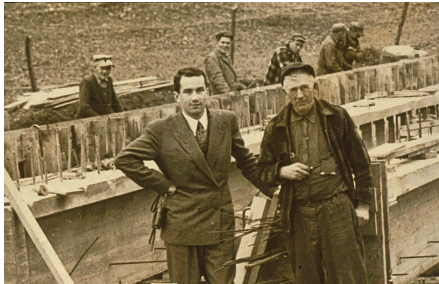
Le chantier de Griffith Road, à East Koy Creek dans le comté du Wyoming, New York. Jean Muller (à gauche) avec le chef du chantier.
