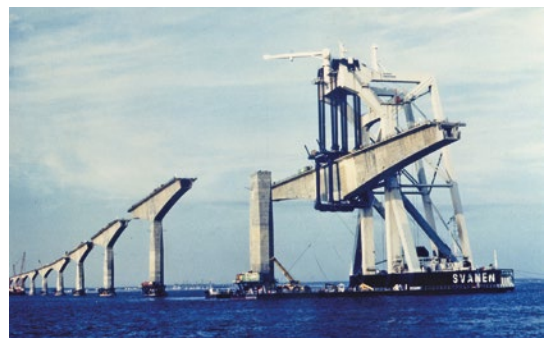
Le Confederation Bridge au Canada, une structure dont la société Jean Muller International pilota les études d'exécution.
