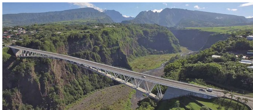
Le pont sur le Bras de la Plaine, sur l'île de la Réunion, pont mixte acier-béton précontraint construit en encorbellement.
