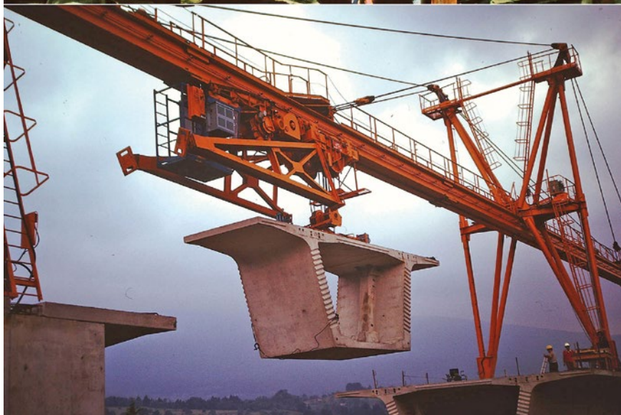
Area, l'une des filiales de Campenon Bernard, était spécialisée dans la préfabrication centralisée de ponts et de passages supérieurs d'autoroute.
