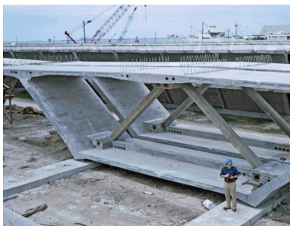
Le voussoir de la Bang Na Expressway, à Bangkok.
