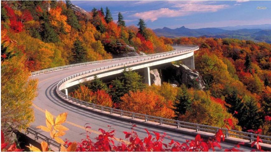
Le Linn Cove Viaduct (en Caroline du Nord), inventé de toutes pièces par Jean Muller, traverse une forêt protégée.
