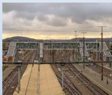
PASSERELLE PA1 EN GARE DE BETTEMBOURG Bettembourg
