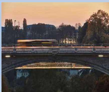
PASSERELLE PIÉTONNE PONT ADOLPHE Luxembourg-Centre
