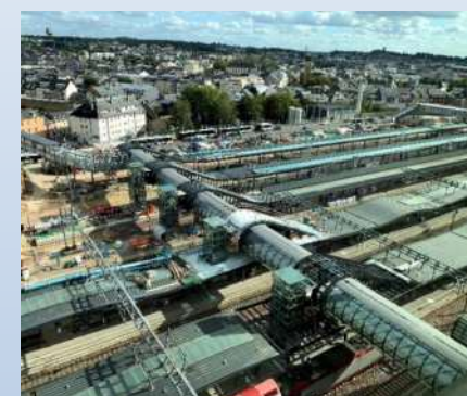
PASSERELLE + QUAIS V & VI Gare de Luxembourg
