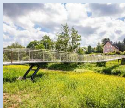
PASSERELLE PIÉTONNE Bissen
