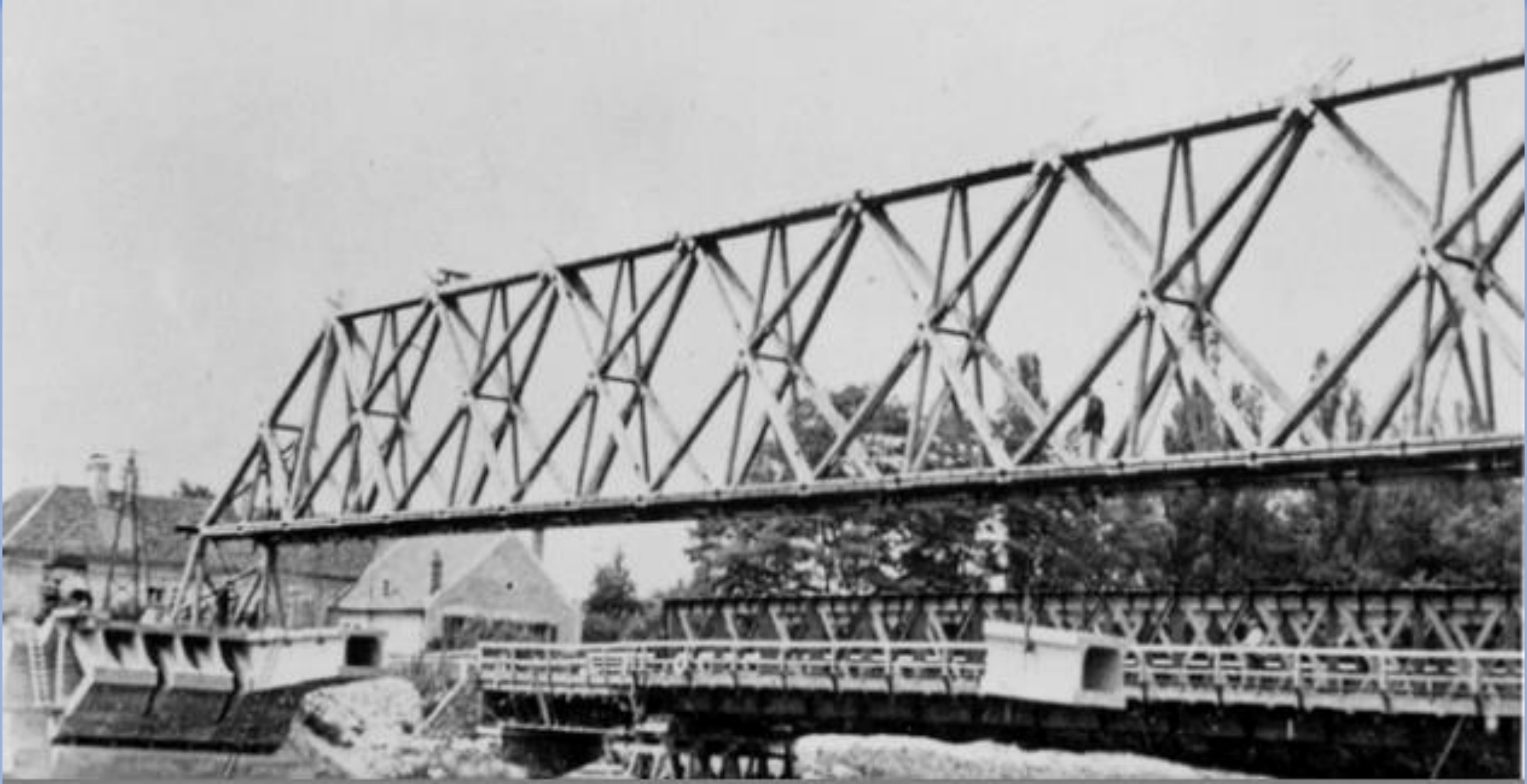
Poutre de pose des voussoirs constituée d'une structure en treillis triangulaire en bois (nœuds en béton), permettant d'acheminer les voussoirs (véritable précurseur des poutres de lancement modernes utilisées aujourd'hui partout dans le monde pour les ponts en encorbellement)
