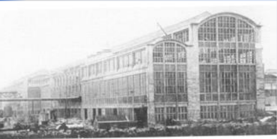
Les Aciéries de Caen Vue d'ensemble
