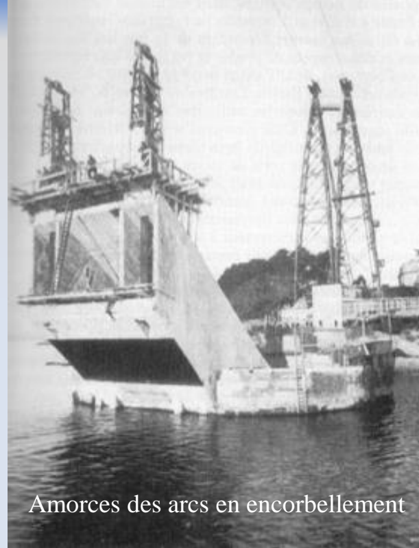
Caisson pour réaliser les fondations en rivière
