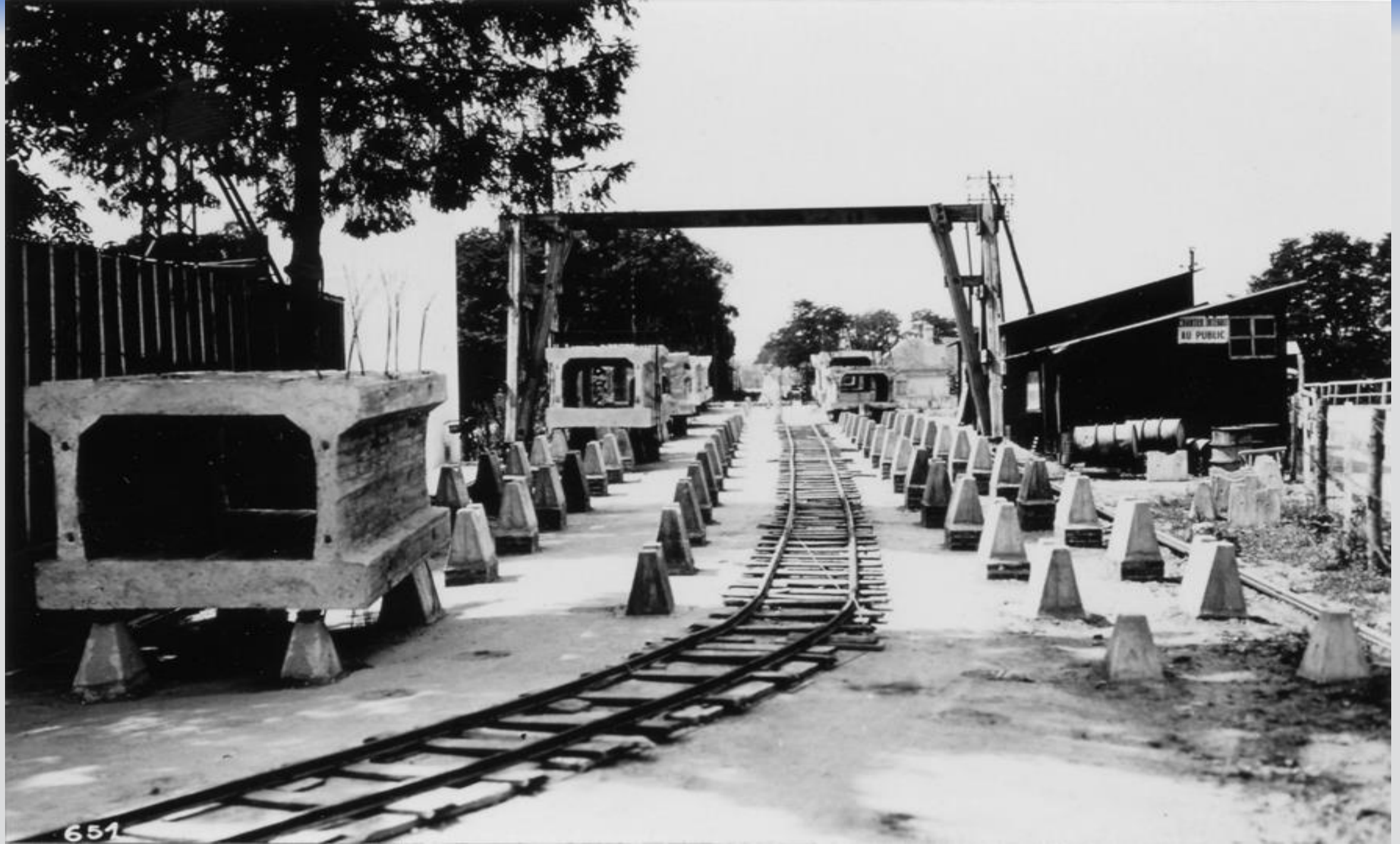
Aire de préfabrication des voussoirs
