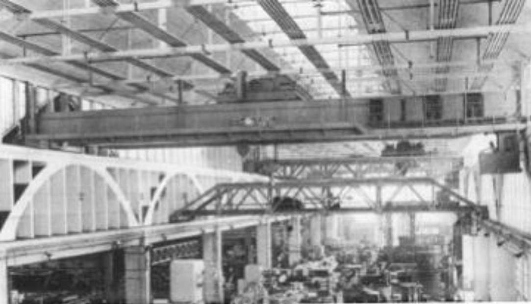
Usine Schneider au Creusot poutre rail pour pont roulant de 100 t
